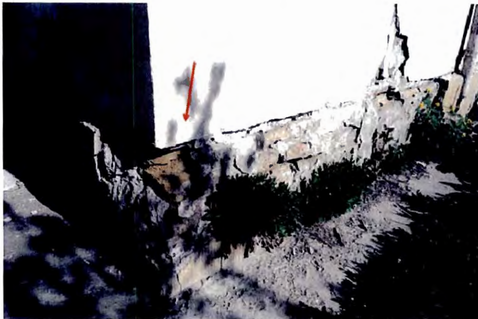
Degradare accentuată la nivelul soclului
