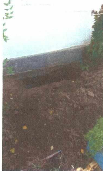
Foto 4 – Sondaj realizat pentru determinarea cotei de fundare și determinarea materialelor folosite la fundații
