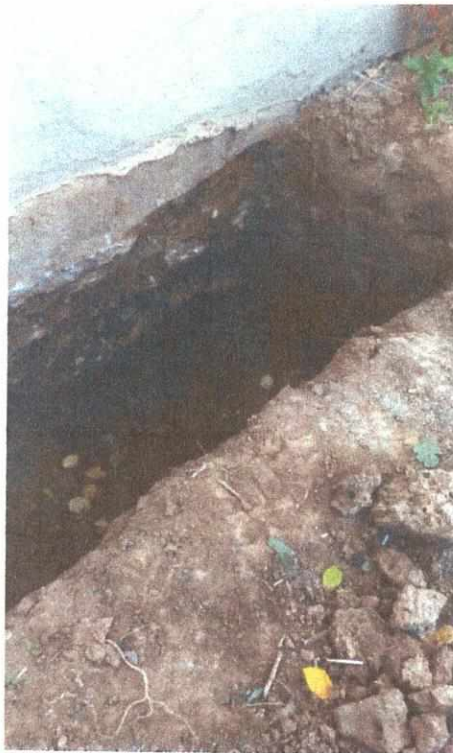
Foto 6 - Sondaj realizat pentru determinarea cotei de fundare și determinarea materialelor folosite la fundații
