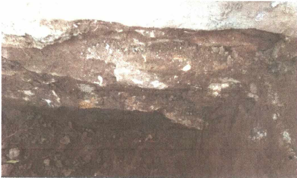
Foto 7 - Sondaj realizat pentru determinarea cotei de fundare și determinarea materialelor folosite la fundații
