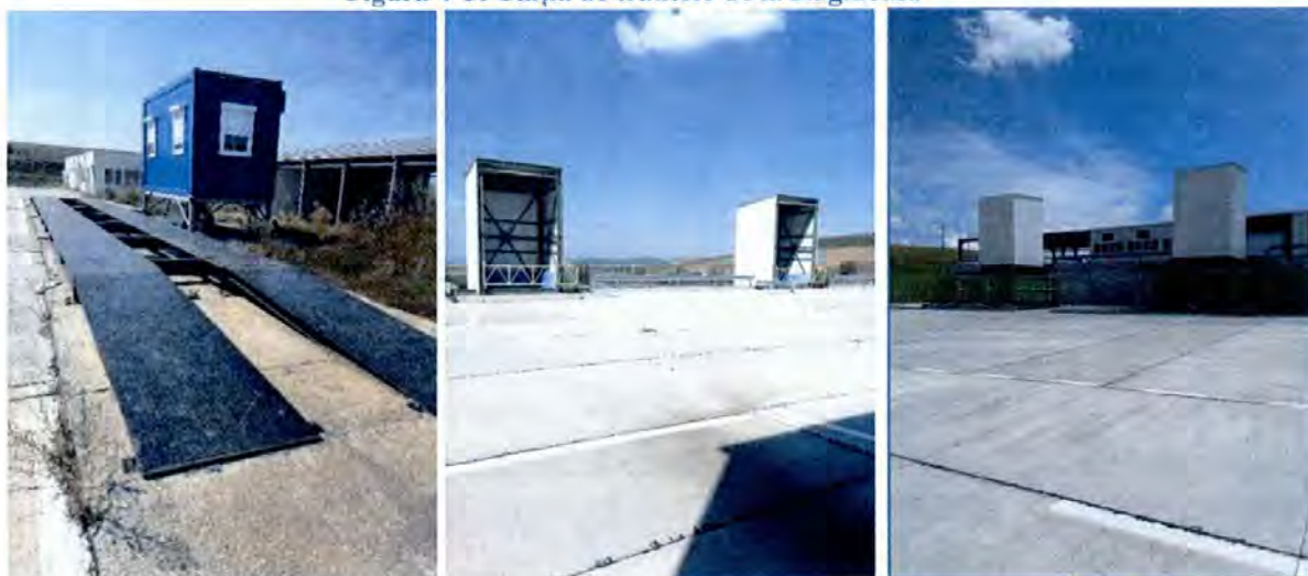
Figură 4-10 Stația de transfer de la Ruginoasa
