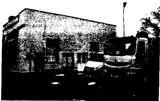
Foto 45 – Corp C1 – Hala reparatii
