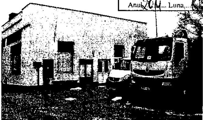
Foto 45 – Corp C1 – Hala reparatii
