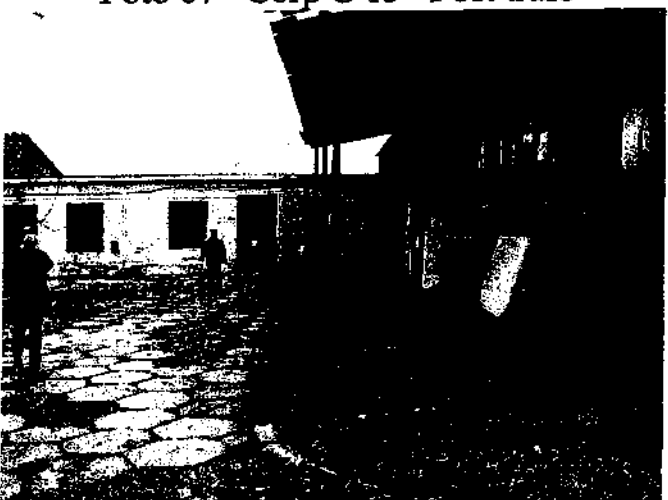
Foto 69- Corp C 11 - Rampa
